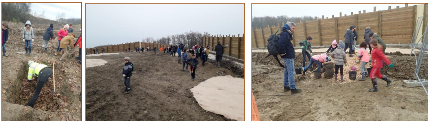
Les élèves en pleine action pour construire des aménagements pour accueillir la faune sur l'écopont © Luc Mery et Jacky Lachenal
