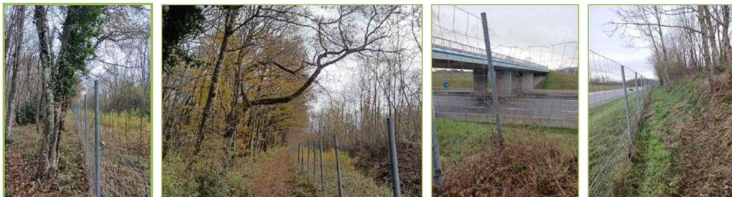
Arbres à proximités de la clôture pouvant être utilisés comme support pour passer par-dessus - clôture trop basse, en pied de talus ou affaissée – voici quelques exemples rencontrés qui peuvent faciliter l'accès des lynx sur l'autoroute © Luc Mery
